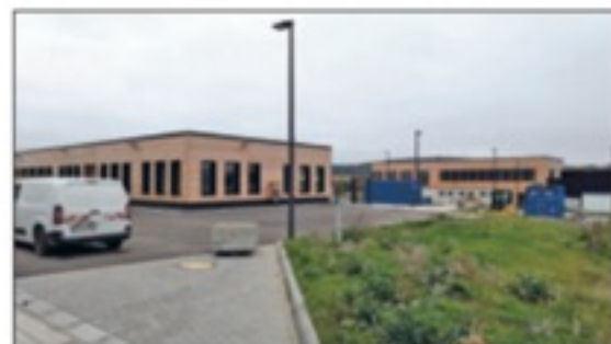
Die Baustelle des zentralen Feuerwehrgerätehauses und des Bauhofes am Ortsrand des Ortsteils Rodheim-Bieber ist bereits weit voran geschritten. (Fotos: SV)
