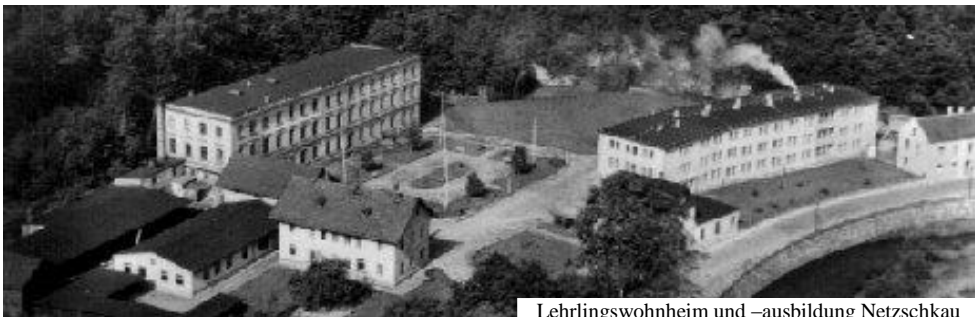
Lehrlingswohnheim und –ausbildung Netzschkau
